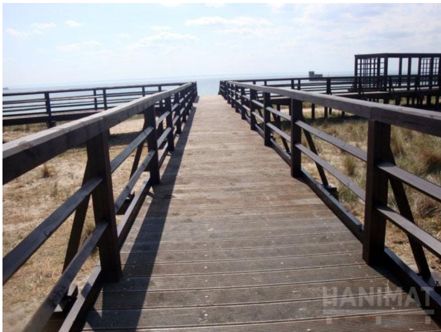
Fotografia 1. Rozwiązania konstrukcyjne z zastosowaniem gotowych prefabrykatów typu Hanimat na wybrzeżu wydmy w Helu.
