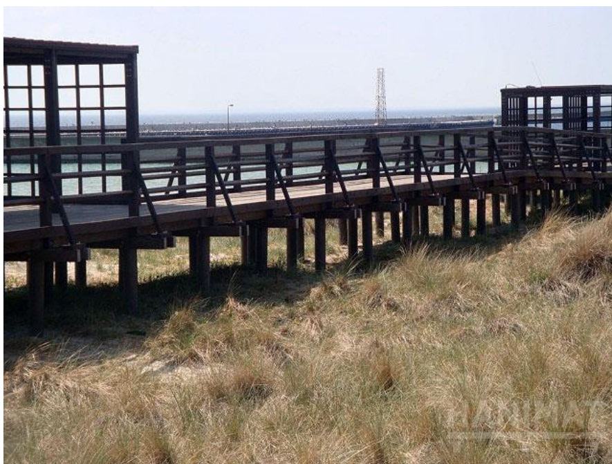
Fotografia 2. Rozwiązania konstrukcyjne z zastosowaniem gotowych prefabrykatów typu Hanimat na wybrzeżu wydmy w Helu.
